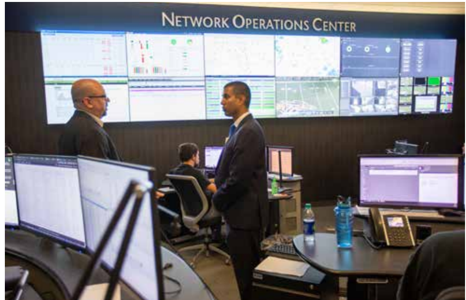
Inside Midco’s NOC
